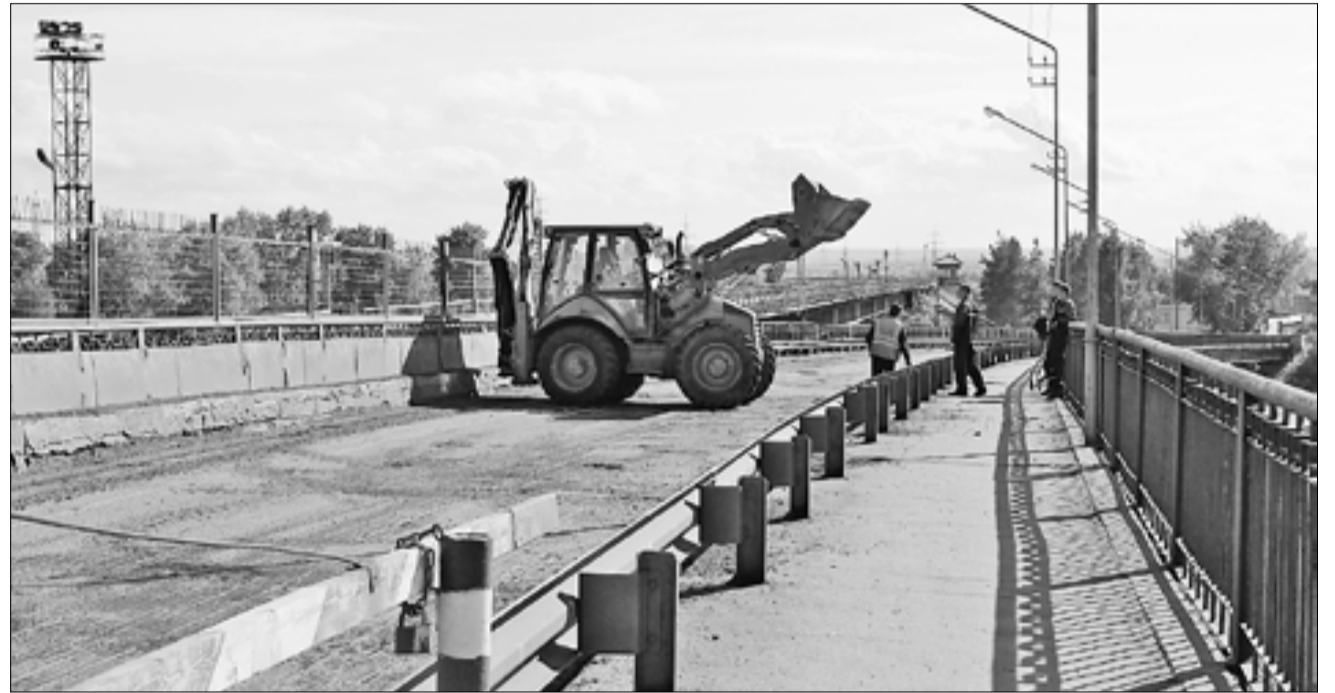
■ Северодвинский мост «переодевают» в новый асфальт. фото: ГЕОРГИЙ ГУДИМ-ЛЕВКОВИЧ
